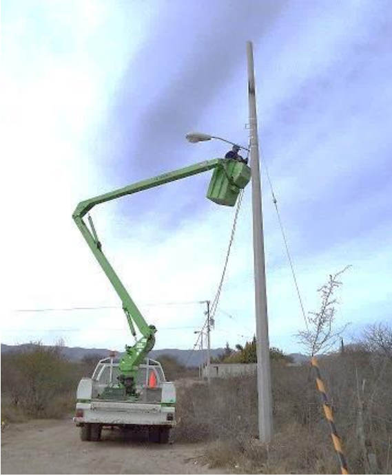
Instalación de luminaria calle San Juan, Fracc. San Ramón.
