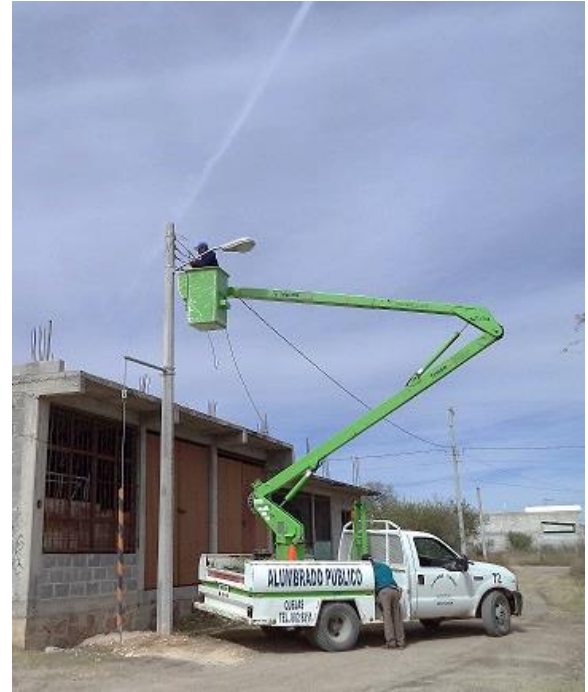
Instalación de luminaria calle Laguna Bosque Azul, Col. República.
