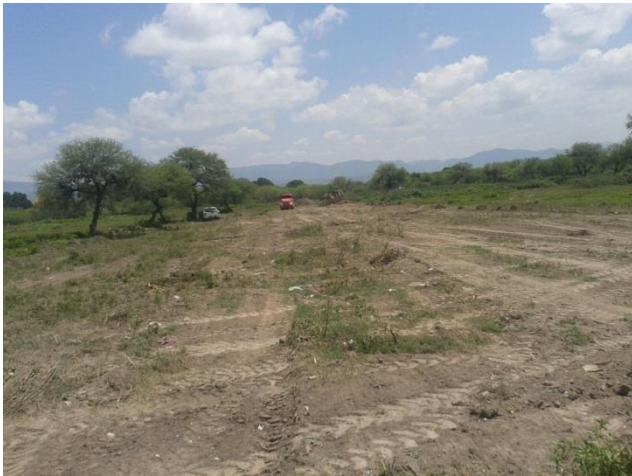
Ilustración 2.- Construcción de primera etapa del Lienzo charro mpal.
