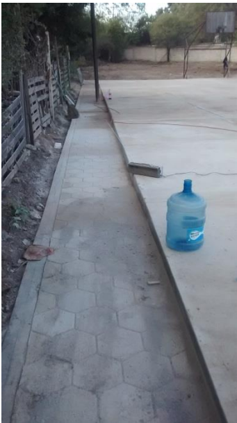
ILUSTRACIÓN 4.- PLAZA MMT BANQUETA TERMINADA.
