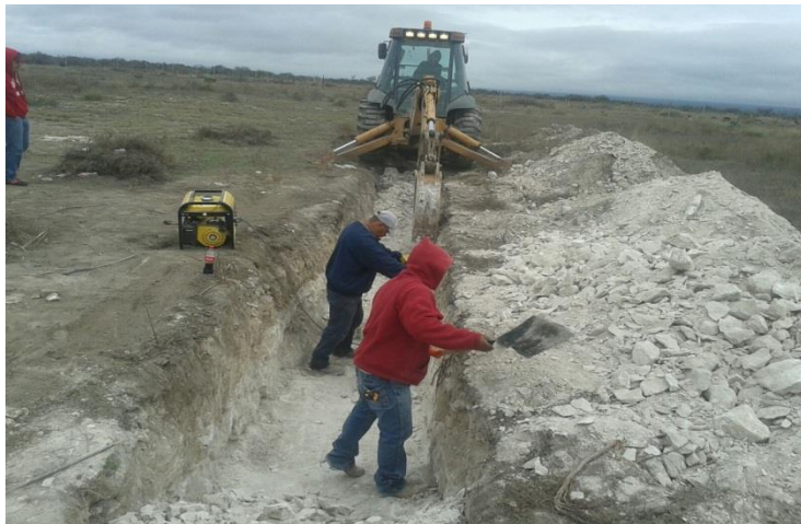
ILUSTRACIÓN 2.- TRABAJOS EN LO QUE SERÁ EL LIENZO CHARRO MUNICIPAL.
