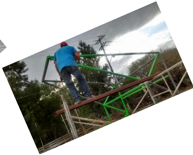
ILUSTRACIÓN 8.- PLAZA MMT PINTURA BASE PORTERÍA.
