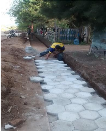
ILUSTRACIÓN 3.- PLAZA MMT, ADOQUINADO.
