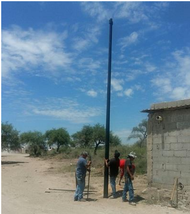
Colocación de poste metálico e instalación de luminaria en la calle Alfonso Reyes, Fracc. Guadalupe.
