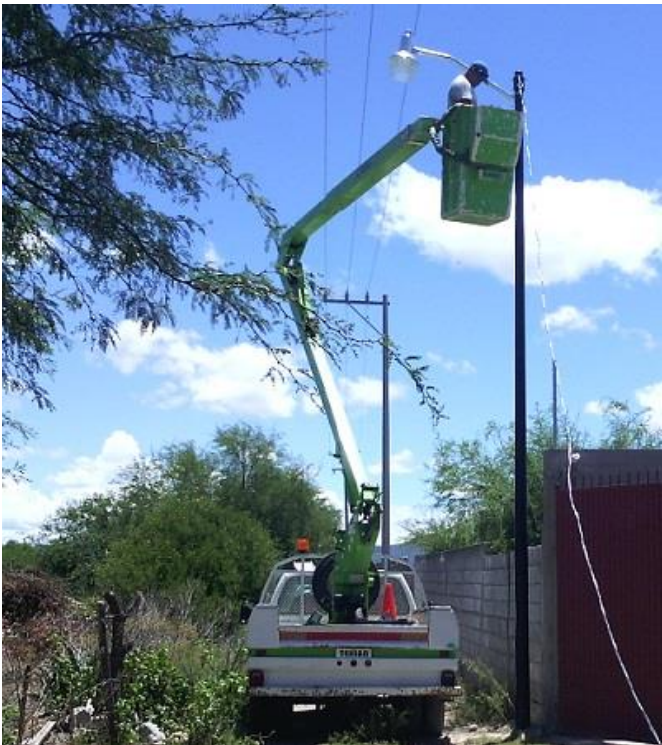
Colocación de poste metálico e instalación de luminarias en Callejón Antiguo en el Ojo de Agua.
