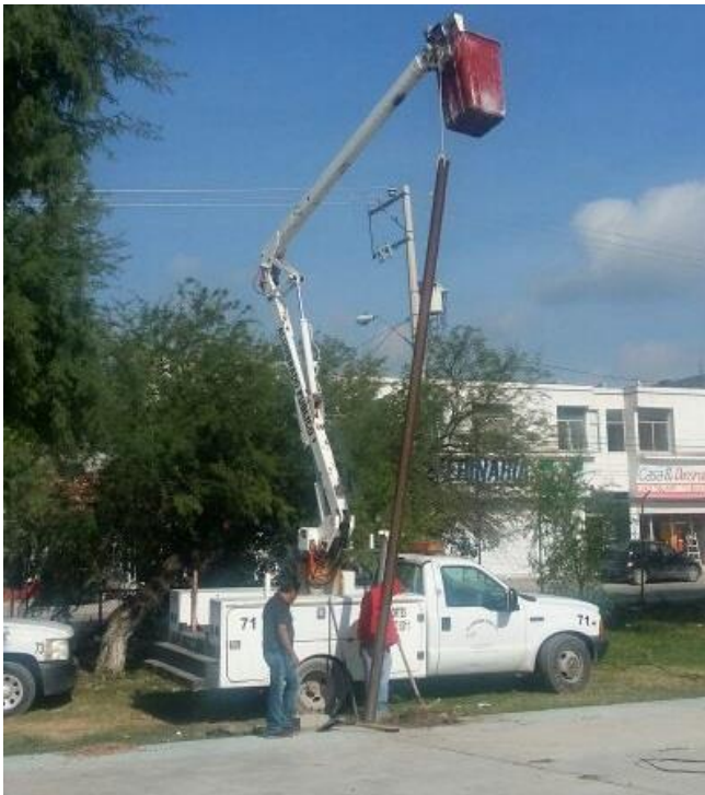
Colocación de poste metálico e instalación de reflectores en la Cancha ubicada en la calle Hidalgo.
