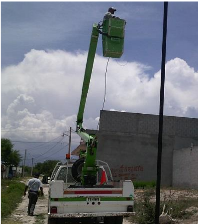
Instalación de postes metálicos y luminarias en la calle de San Luis de la Col. República.
