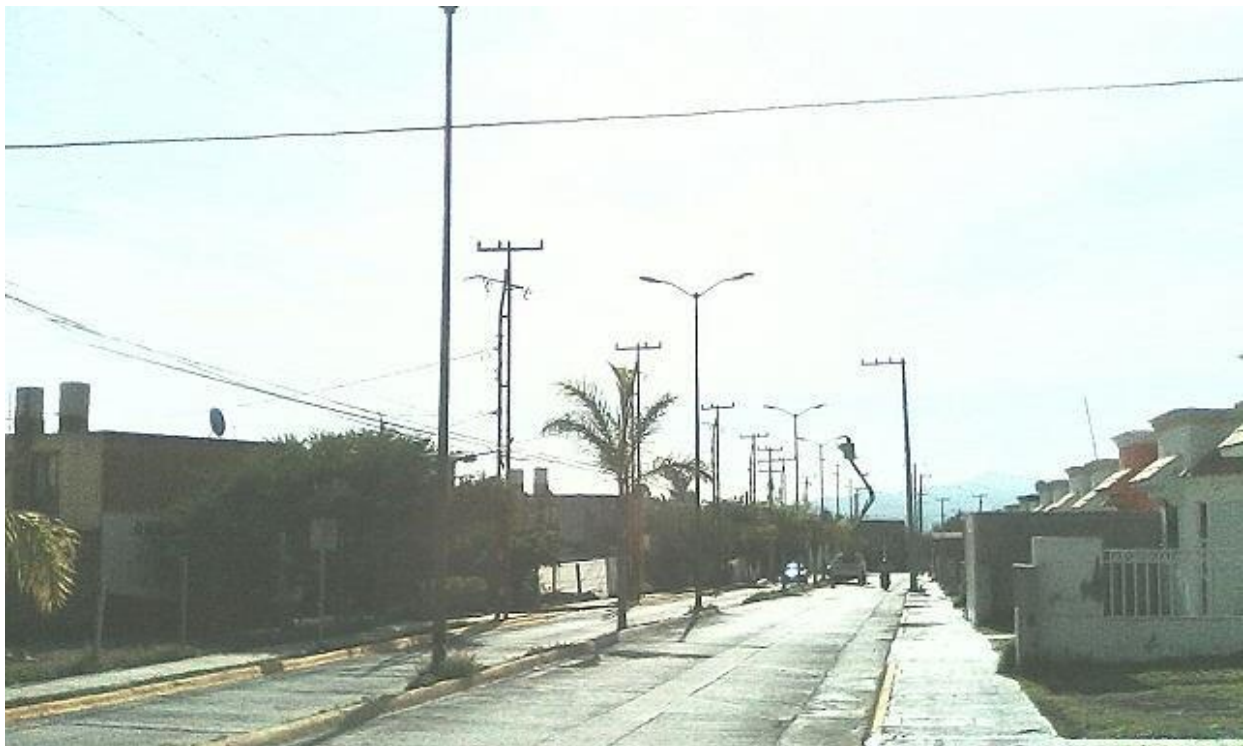
Mantenimiento de luminarias en la Av. Bustamante.
