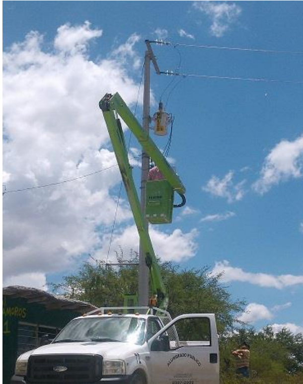
Mantenimiento de luminarias en la Zona Rural.
