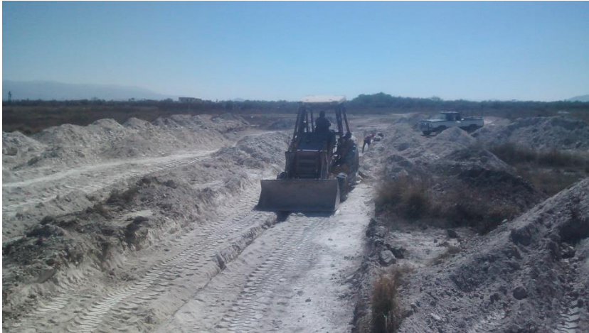
ILUSTRACIÓN 1.- TRABAJOS EN LO QUE SERÁ EL LIENZO CHARRO MUNICIPAL.
